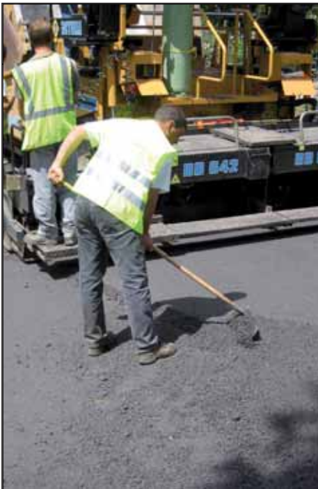
TOTALE RECUPERO, A SEGUITO DI FRESATURA, DEL CONGLOMERATO BITUMINOSO STRADALE.
